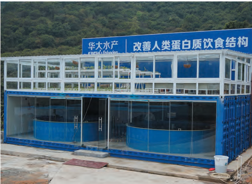
集装箱改造工厂化循环水养殖项目（广东） 海水石斑和淡水宝石斑双系统 共 40 立方养殖水体 密度 60-70 公斤 / 立方
